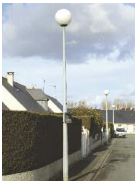
200 000 euros vont être investis dans la rénovation et la mise aux normes de l'éclairage public.
